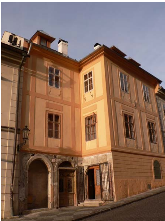
Výsledná obnova, rekonštrukcia klasicistickej úpravy fasády
