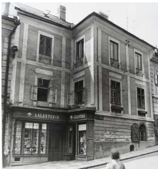
1975, stav pred obnovou fasády
