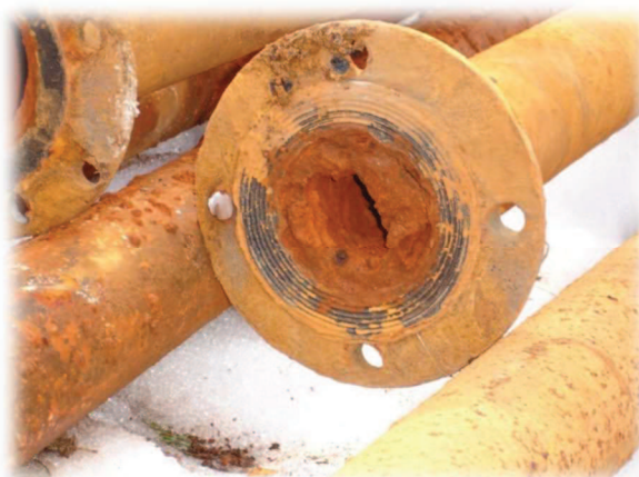
Lažany – výtlačné potrubí čerpadla – železitě inkrustace
