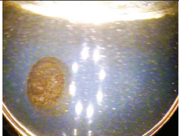
Foto 6: Dosypání vrtu kačirkem, průměr otvoru 52 mm, hloubka 142 m
