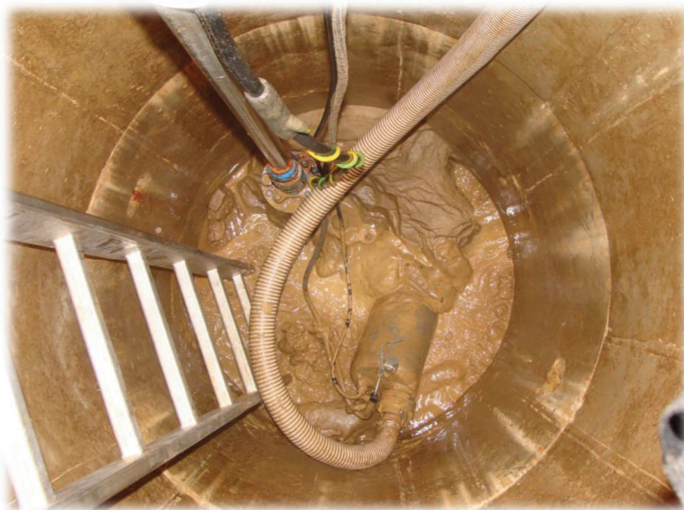
Jemný kal na dně studny při čištění
