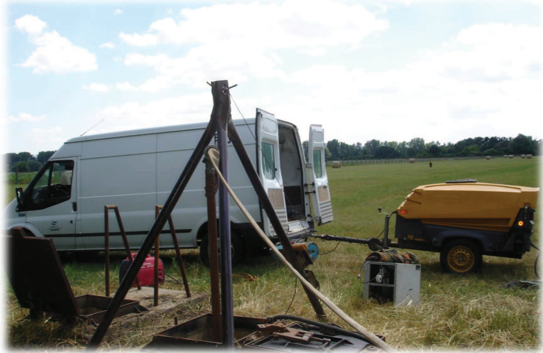
Bzenec (čištění vrtu)
