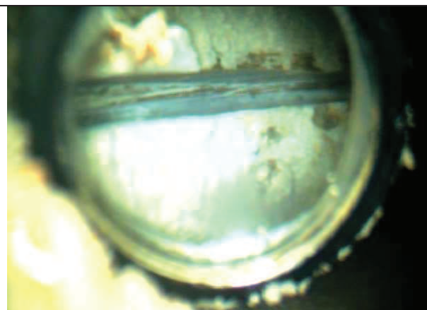
Foto 2: Vodorovný řez v PVC zárubnici realizovaný v hloubce 20 m
