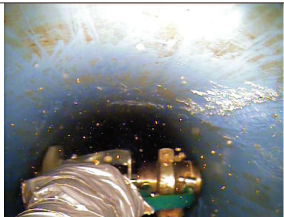
Foto 8: Dosypávání vrtu vnitřkem pažnice, hloubka 142 m
