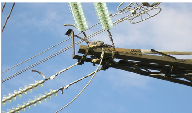
Dostat se s klešťovým DC ampérmetrem k měřenému lanu bylo složité
