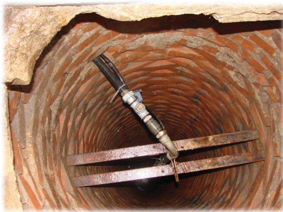
Brno – roubená studna z cihel
