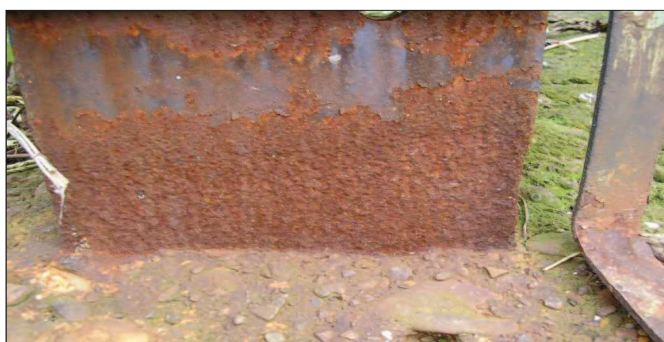
Dostat se s klešťovým DC ampérmetrem k měřenému lanu bylo složité
