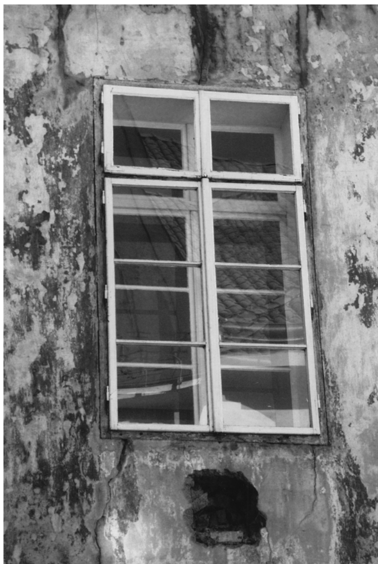
Obr. 6: Slaný (okres Kladno), dům čp. 160, první patro, severní fasáda, dovnitř a ven otvíravé okno. (foto M. Rykl)
