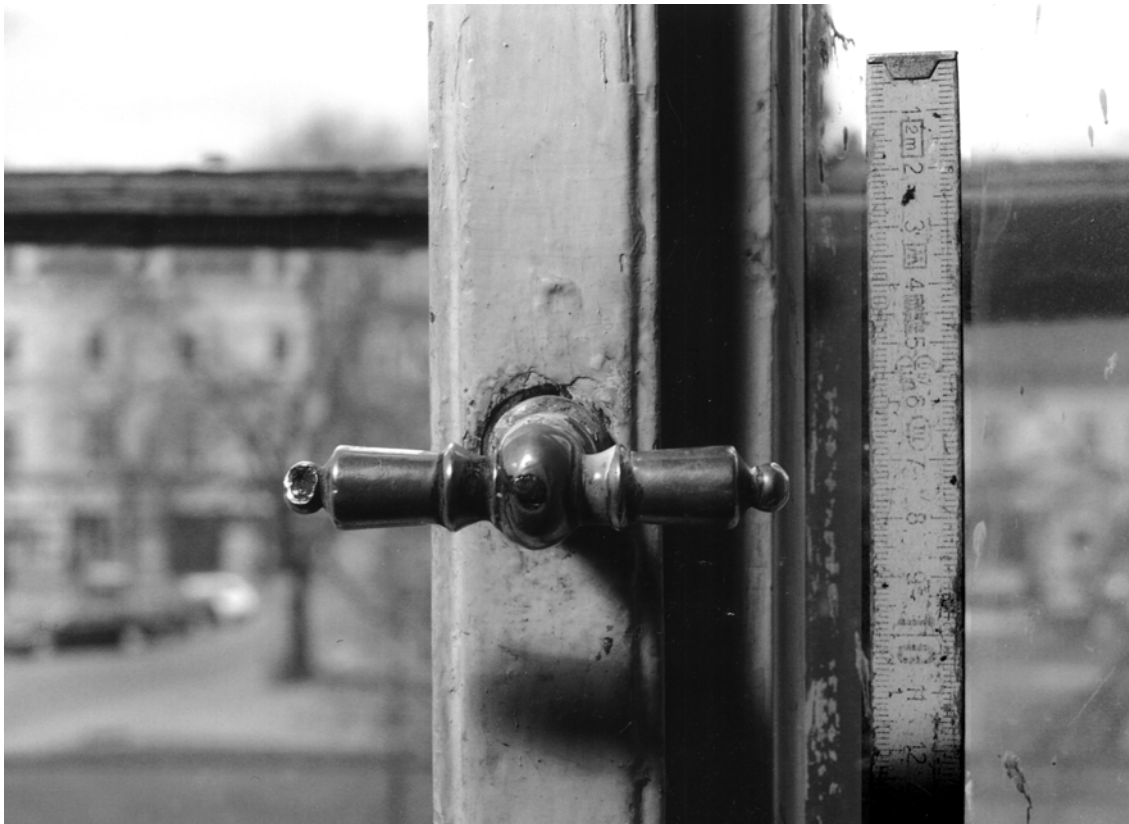
Obr. 10: Slaný, dům čp.1, první patro, severní fasáda, mosazná klika vnitřního okna, pocházející pravděpodobně z poloviny 19. století. (Foto M. Rykl)
