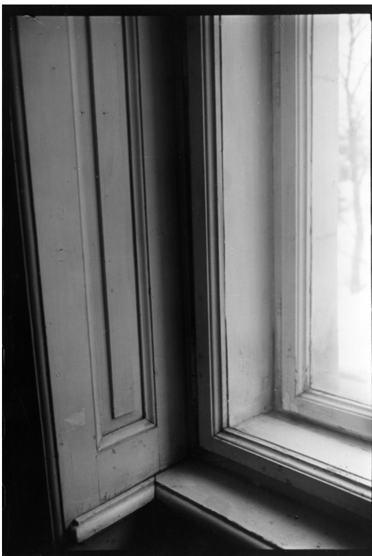
Obr. 7: Praha 2, Vinohrady, dům čp. 1120, první patro, severní fasáda, dvojité, dovnitř otvíravé okno s truhlářským obložením. (foto autor)
